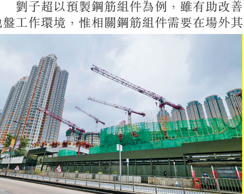
鑽石山公營房屋項目，當中個別工程選用預製鋼筋組件。
