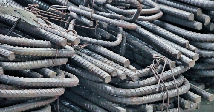
工場利用自動化技術預先進行鋼筋加工。
